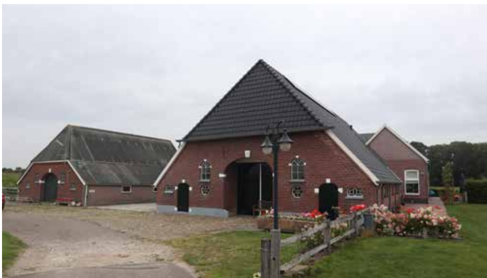
Afbeelding 4. Woonhuis met bijgebouw.
