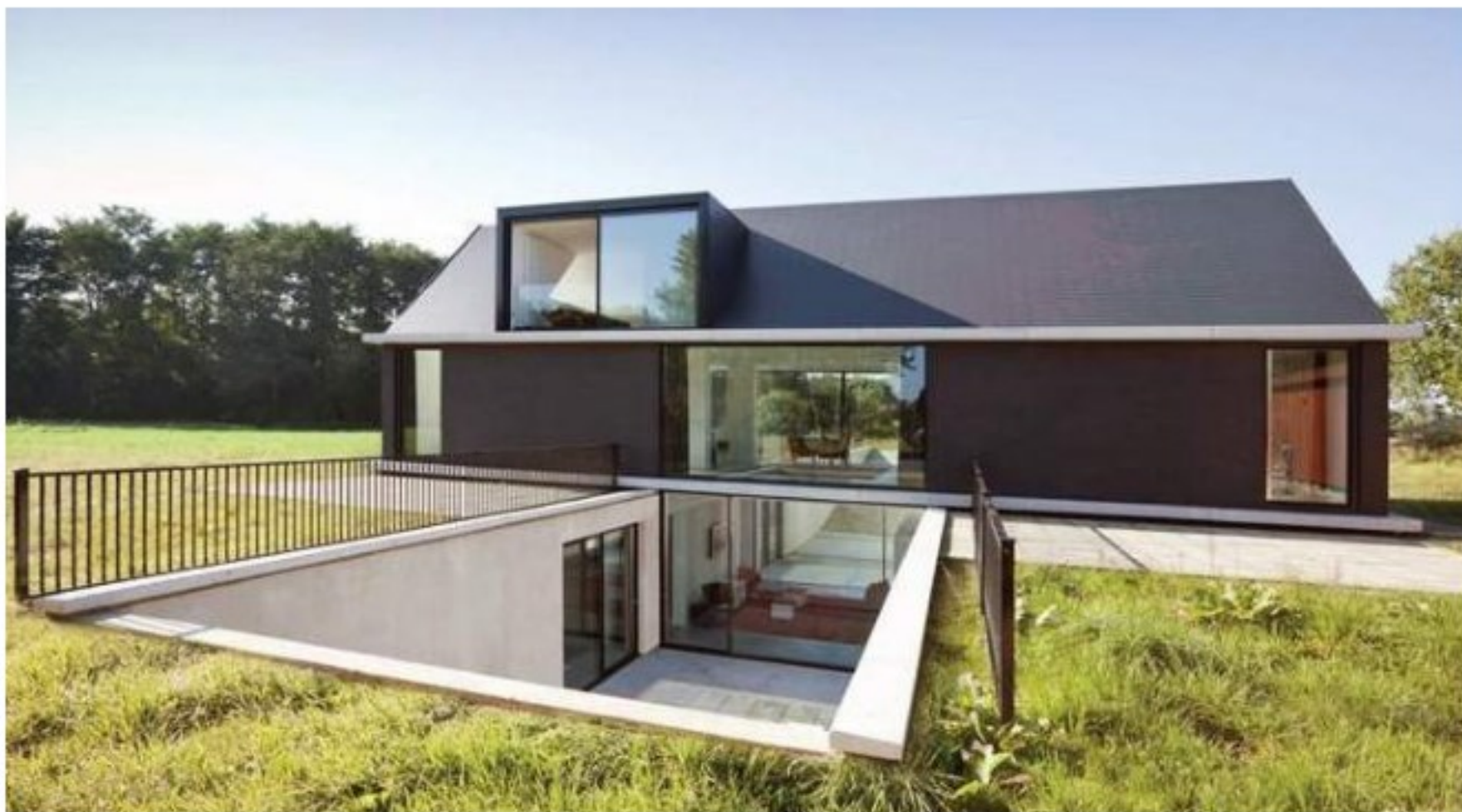
Duidelijke doorzetting (landschappelijke) zichtlijnen door het huis, gebouw ligt 'in' landschap
