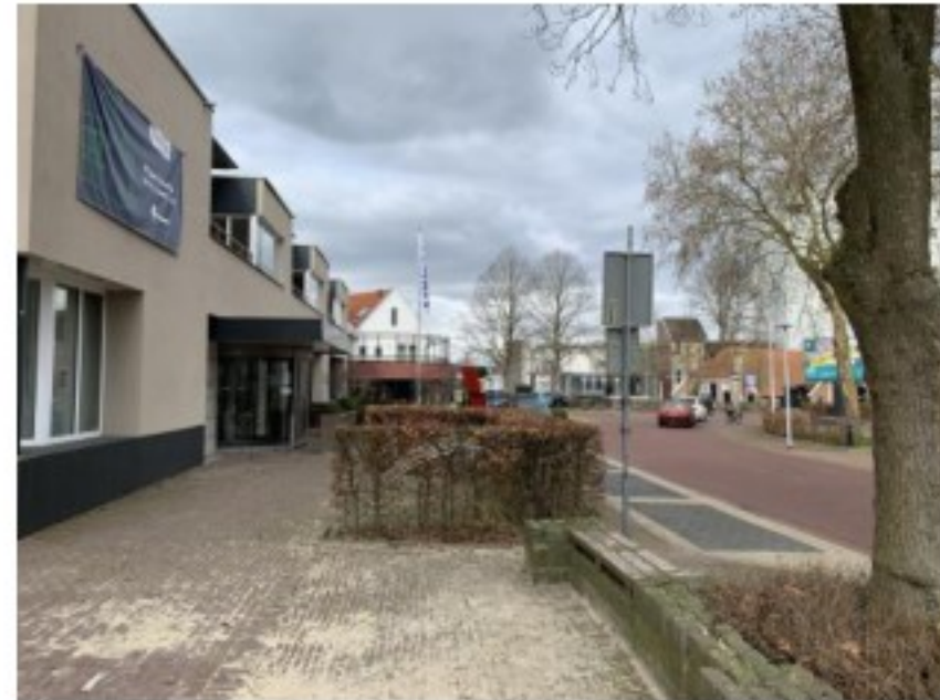
Oostgevel aan de Stationsstraat
