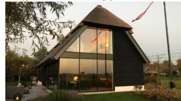
Een schuurwoning in donkere tinten blijft ondergeschikt aan het landschap, maar heeft er door het vele glas wel een geweldige verbinding mee.
