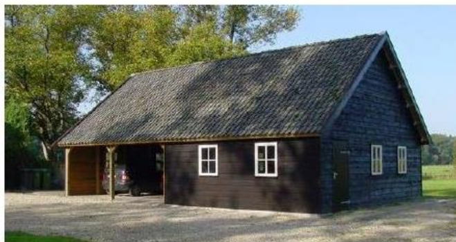
Schuren, ondergeschikt aan woonhuis, halfopen met zichtbare balken. betimmerd met zwart geteerde planken.
