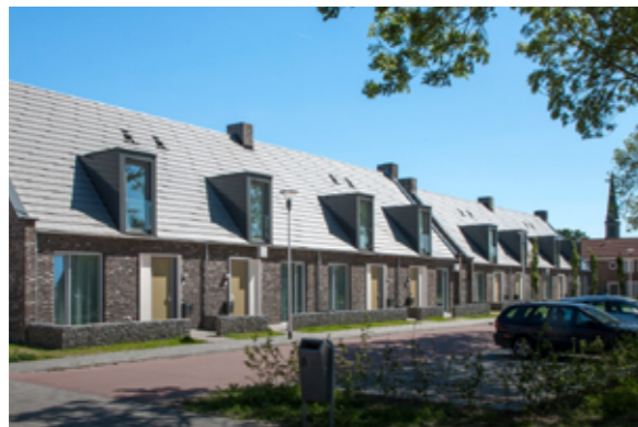
Afbeelding 8: Rijwoningen met dakkapel aan de voorzijde
