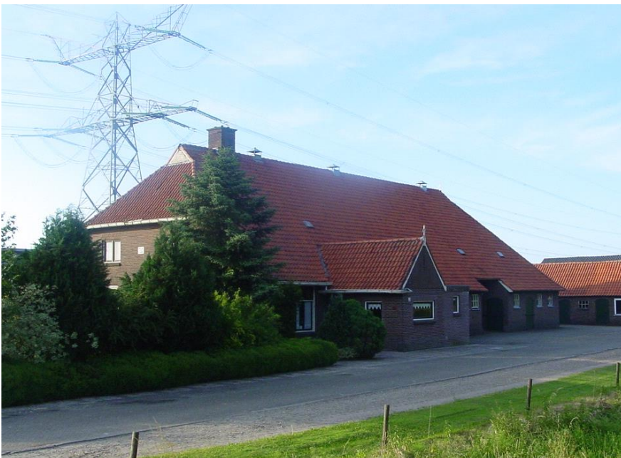
Voorgevel met wolfseind en uilenbord
