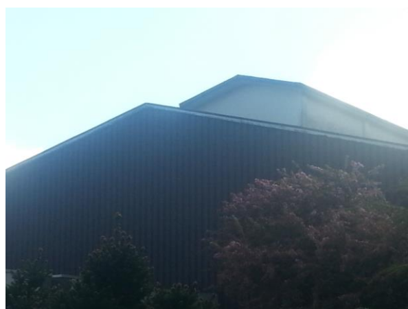
Kopse gevel achterzijde met beplating
