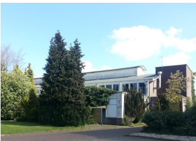
Kopse gevel aan de Bunschotenstraat met aan de voorzijde de aanbouw uit de zestiger jaren
