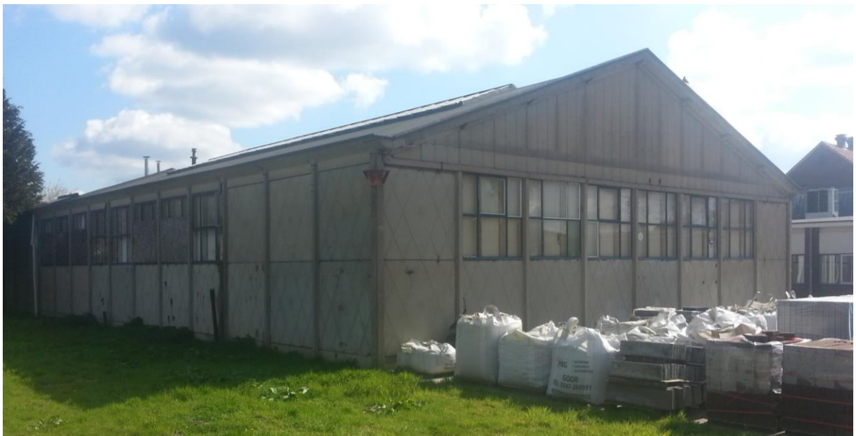
De fabriekshal vanuit de noord-westelijke hoek met duidelijk zichtbaar de 2x 2 meter metende prefab-elementen. Tevens zichtbaar de lichte knik op de dakuiteinden en de gemonteerde lichtkap
