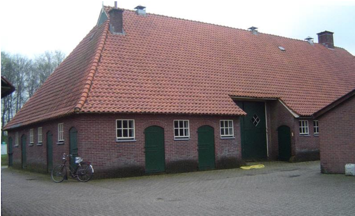
Afhangende achtergevel met uilenbord en in de zijgevel de terugliggende dwarsdoorrit met schapstenen.
