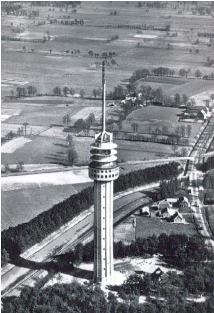
foto 1958 totale hoogte toren 173 meter
