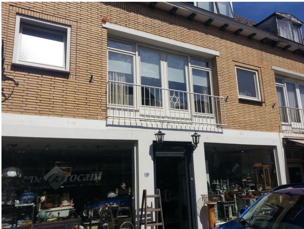
De betonconstructie bij de etalages en het ijzeren hekwerk met ster
