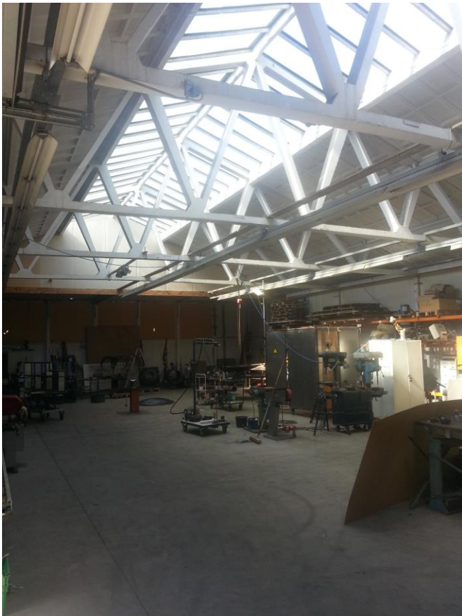
Een indruk van de constructie binnen met de lichtkap
