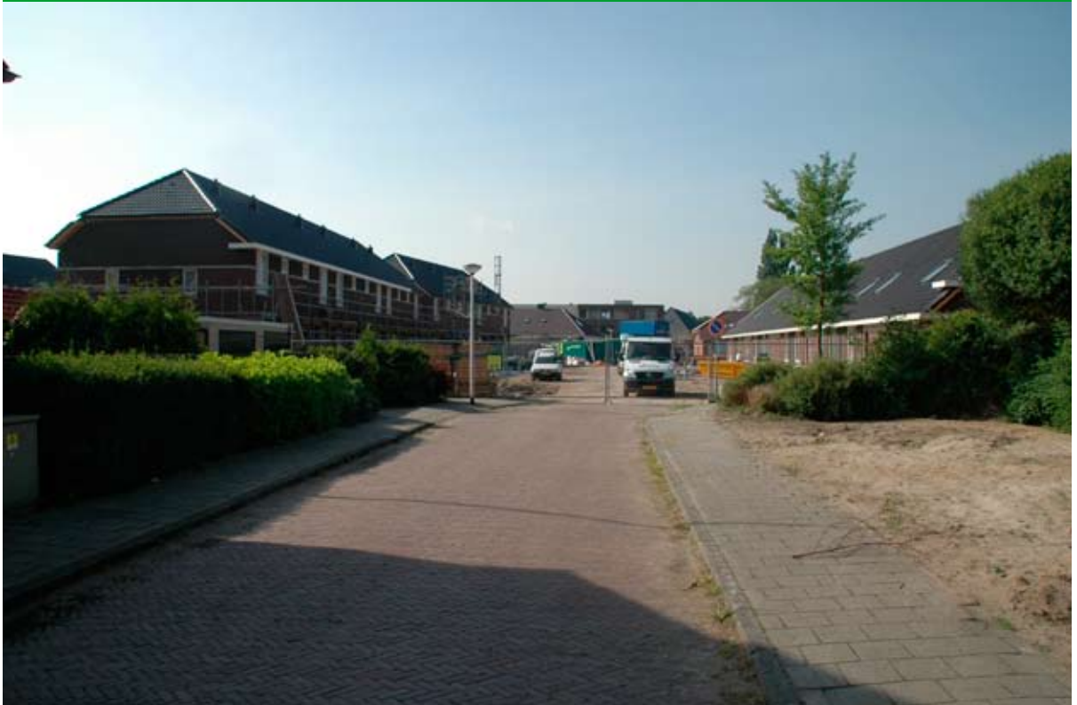
Nieuwbouw aan de W. van der Sluisstraat
