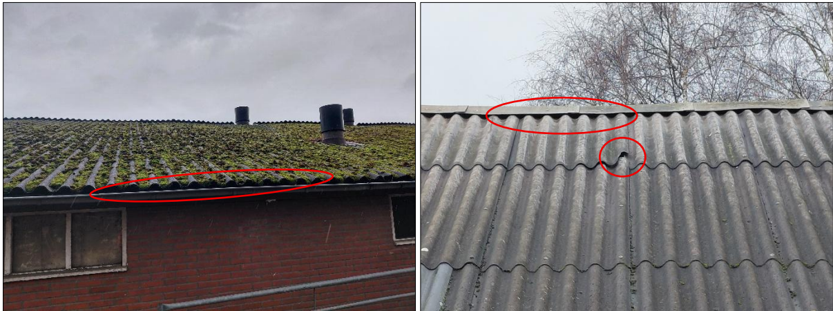
Openingen die toegang bieden tot potentiële nestplaatsen, via dakgoten (afbeelding links) of via nokbedekking of beschadigingen in de golfplaten (afbeelding rechts)
